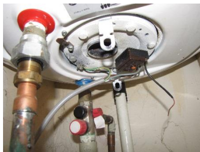
Figure 1 : La canalisation en cuivre est en contact avec le ballon en acier
